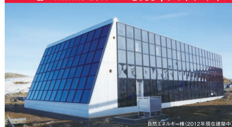
自然エネルギー棟(2012年現在建築中)
